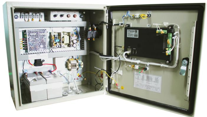
Das Panel verfügt über einen externen Netzschalter, der das Vorhandensein von 230-V-Netzspannung und 24-V-Spannung für die Stromversorgung des Rekorders und der RS485-Leitung anzeigt. An der Unterseite verfügt die Abschirmung über Kabeldichtungen zur Montage von Stromkabelleitungen, Ethernet-, RS485- und Koaxialkabeln externer 4G/LTE- und ZigBee 868 MHz-Antennen.
